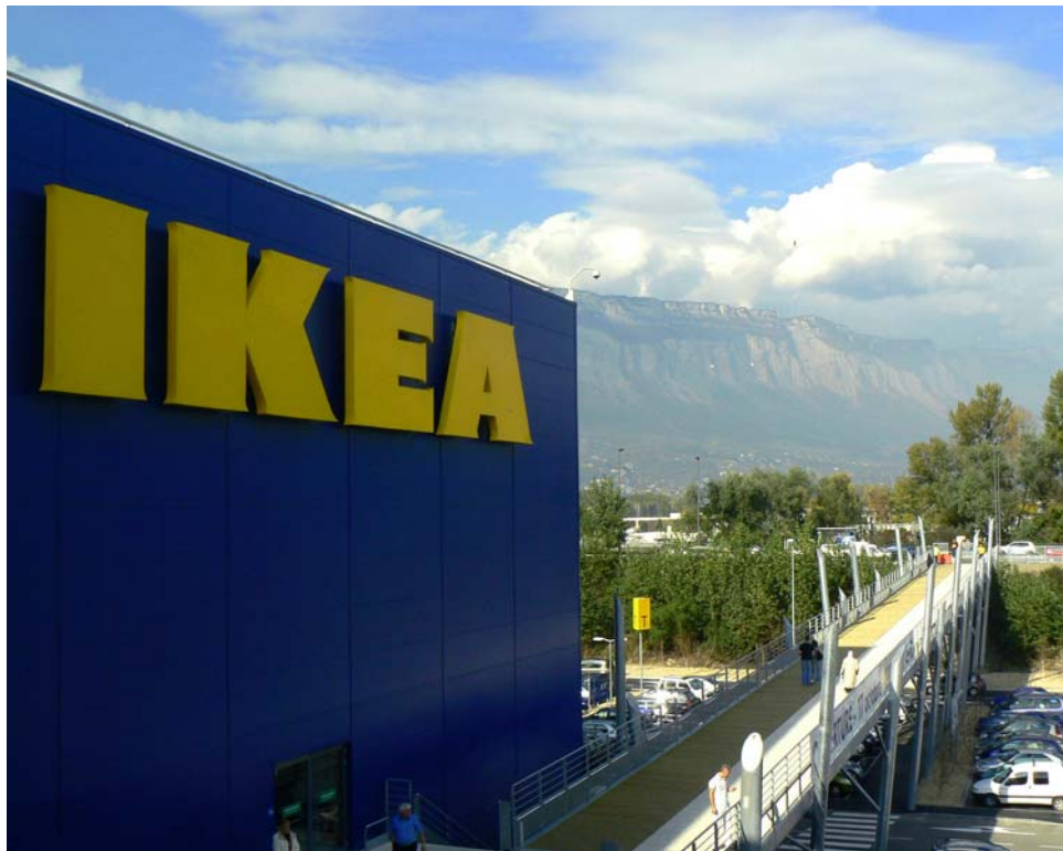
Bildunterschrift: IKEA Frankreich investiert zur CCTV-Überwachung seines neuen Flagship-Stores in Grenoble in die IP Komplettlösung von IndigoVision.
