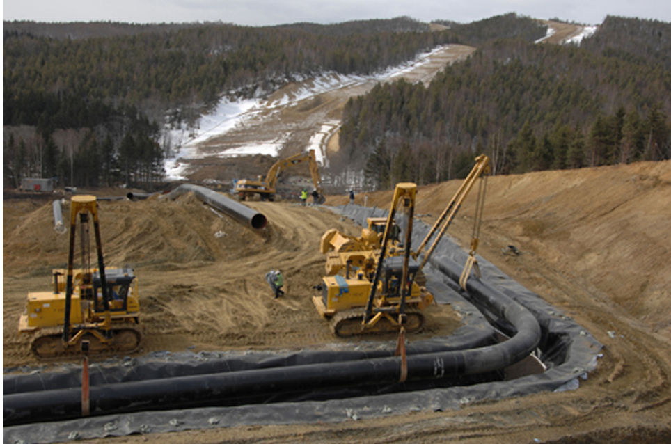
Foto: Bau der 800 km langen Festland-Pipeline für Sachalin-2 (mit freundlicher Genehmigung von Sakhalin Energy)
